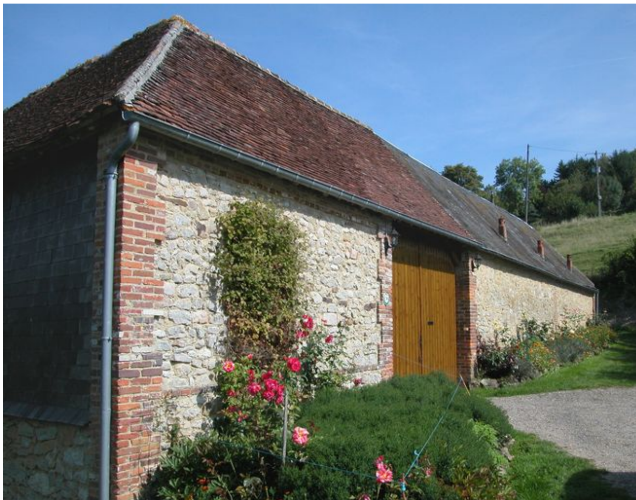
L'entrée charretière cantonnée des granges fermant la propriété à l'avant.
