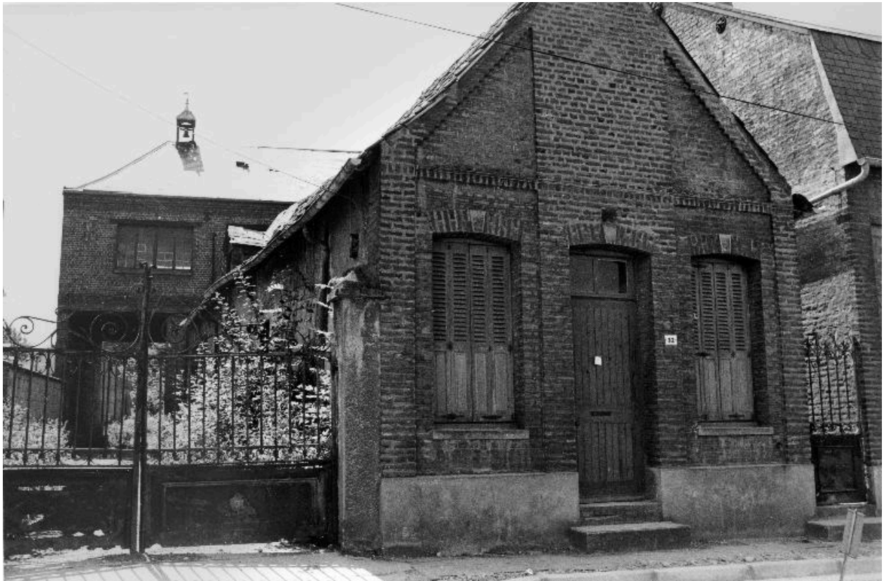
Conciergerie et atelier de fabrication, en 1990.
