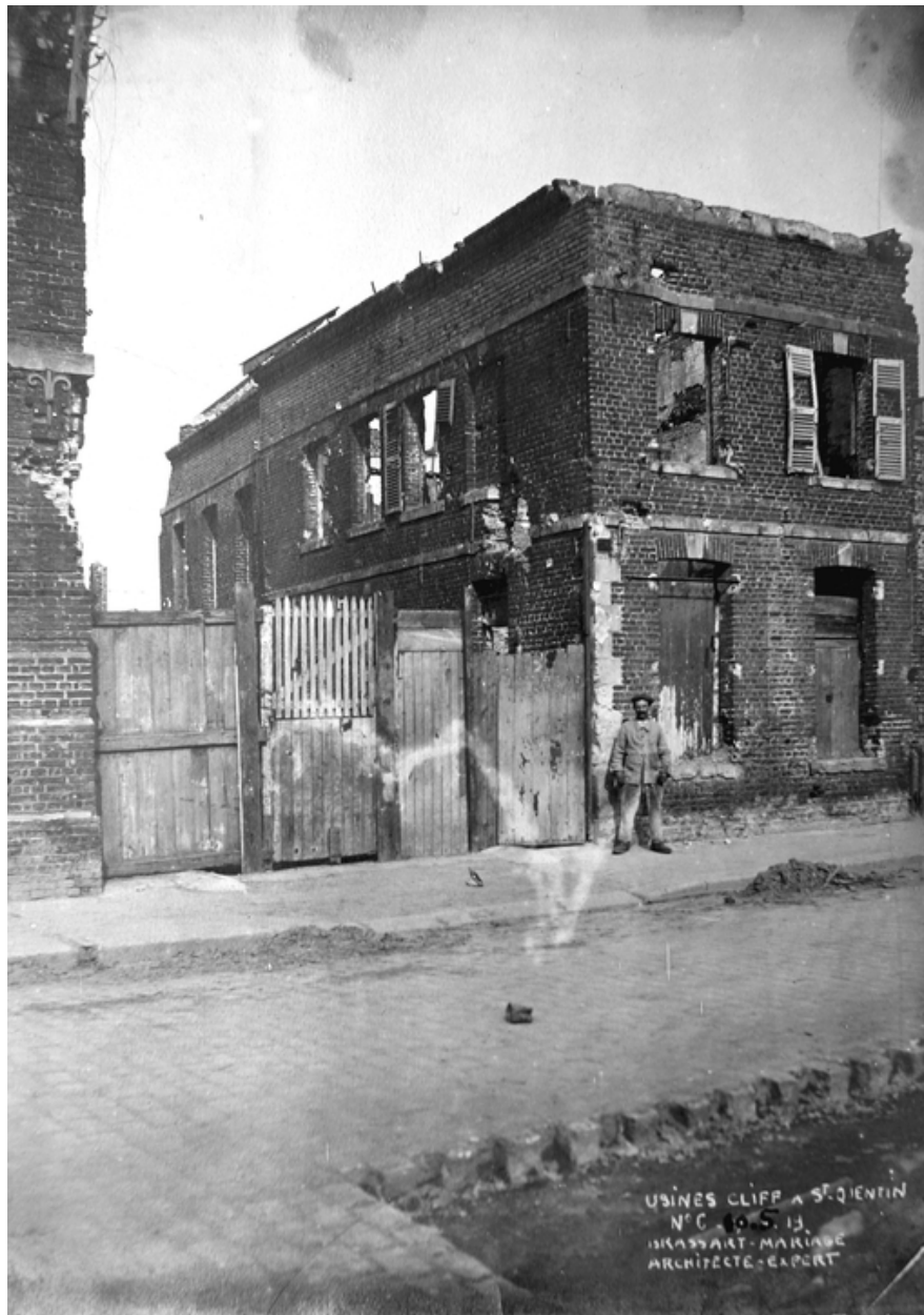
Entrée de l'usine et conciergerie, par Brassart-Mariage, mai 1919 (AD Aisne).
