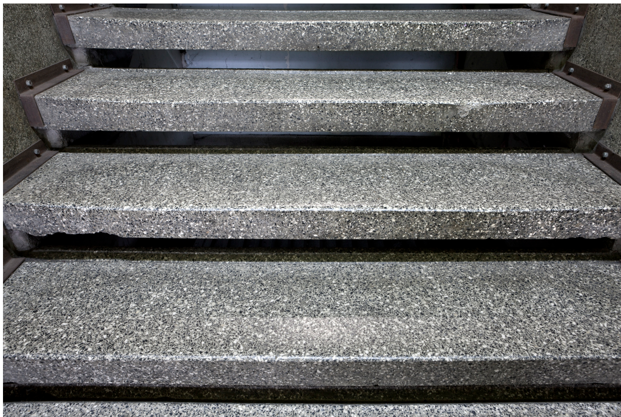
Escalier intérieur externat (lycée puis collège) : détail des marches, 2016 (détruit en 2016).
