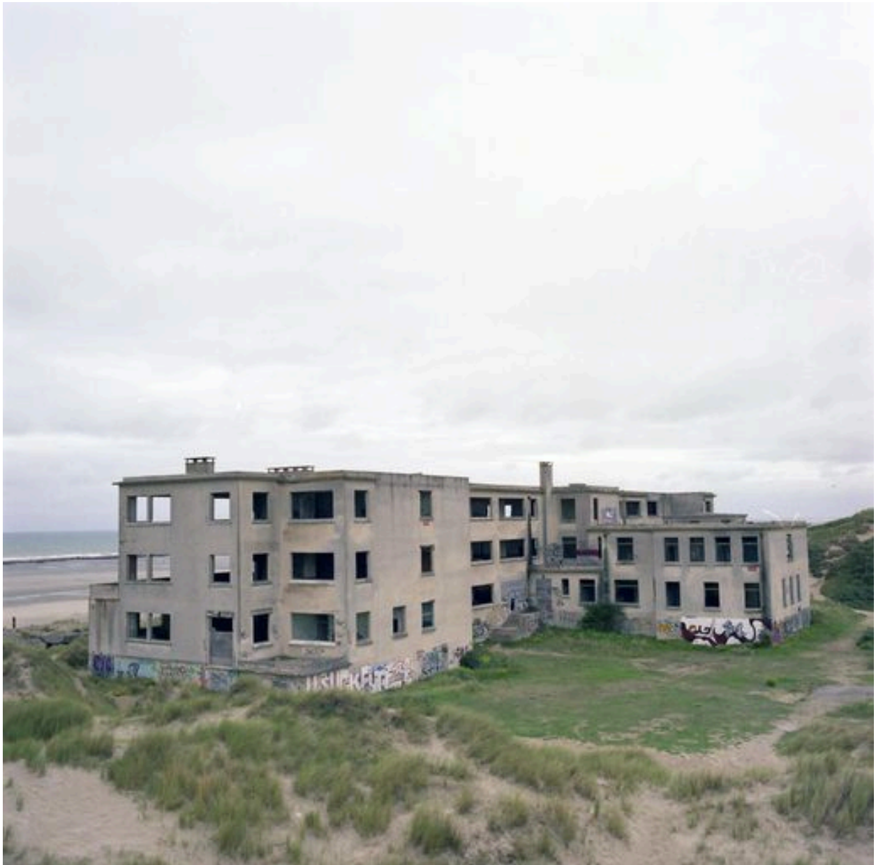
Élévation postérieure, vue générale prise de trois-quarts gauche.
