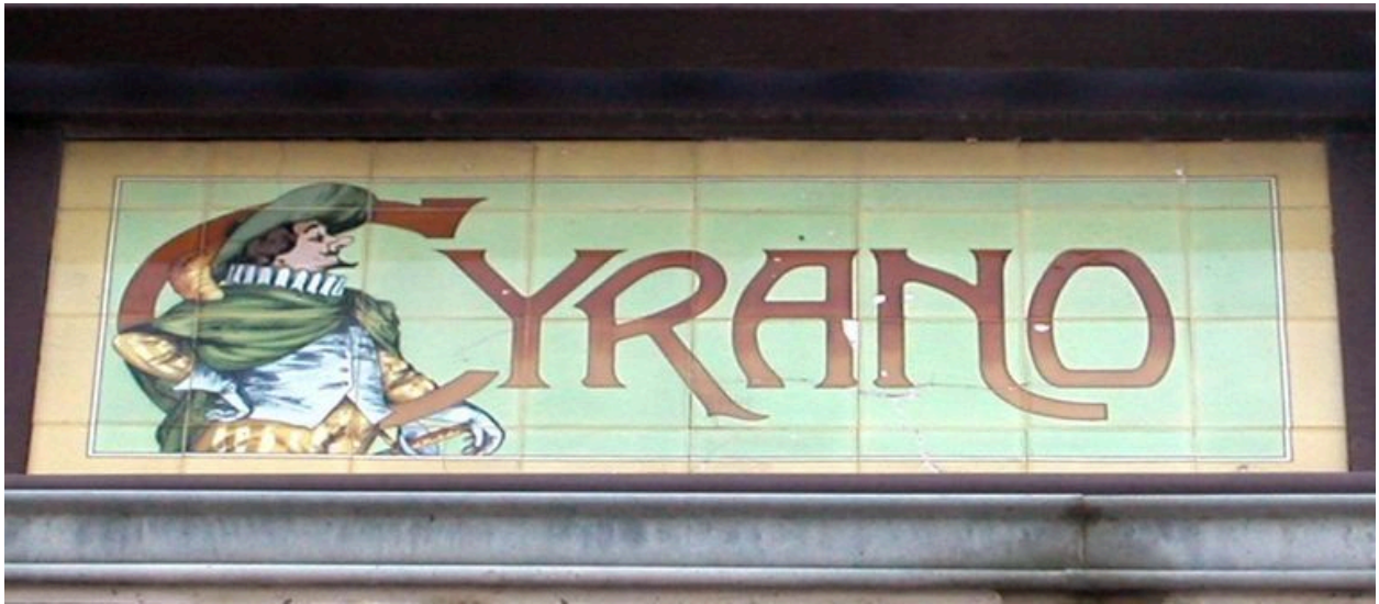
Détail du carreau de céramique portant appellation.
