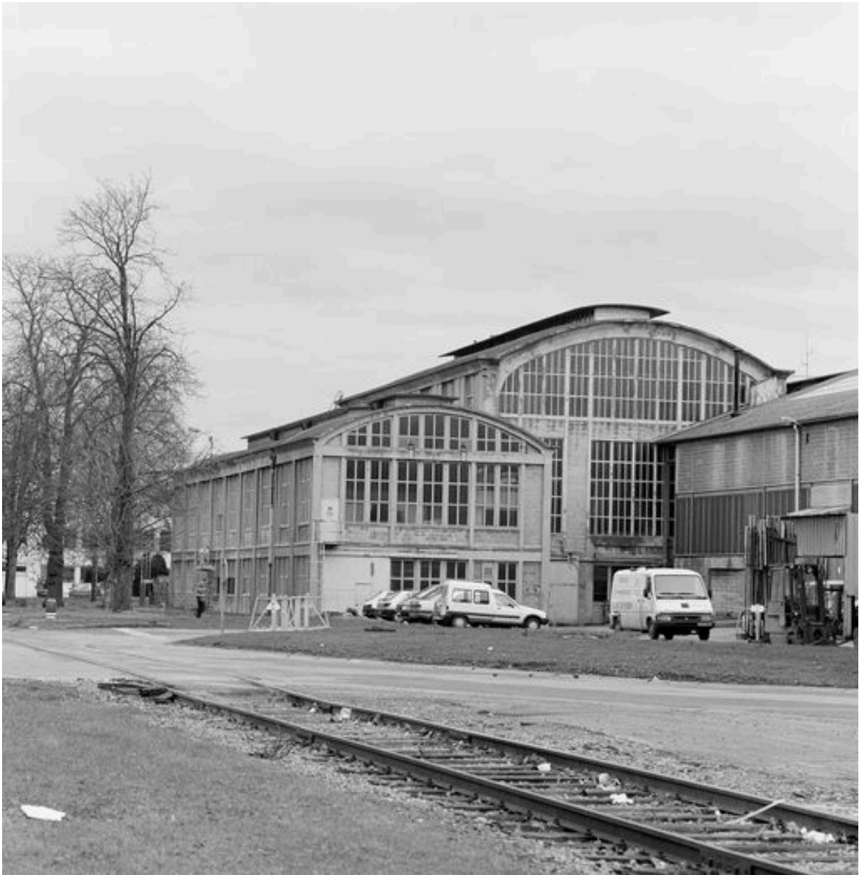
Vue d'ensemble du bâtiment de la centrale électrique, dite centrale ouest, construite en 1923.
