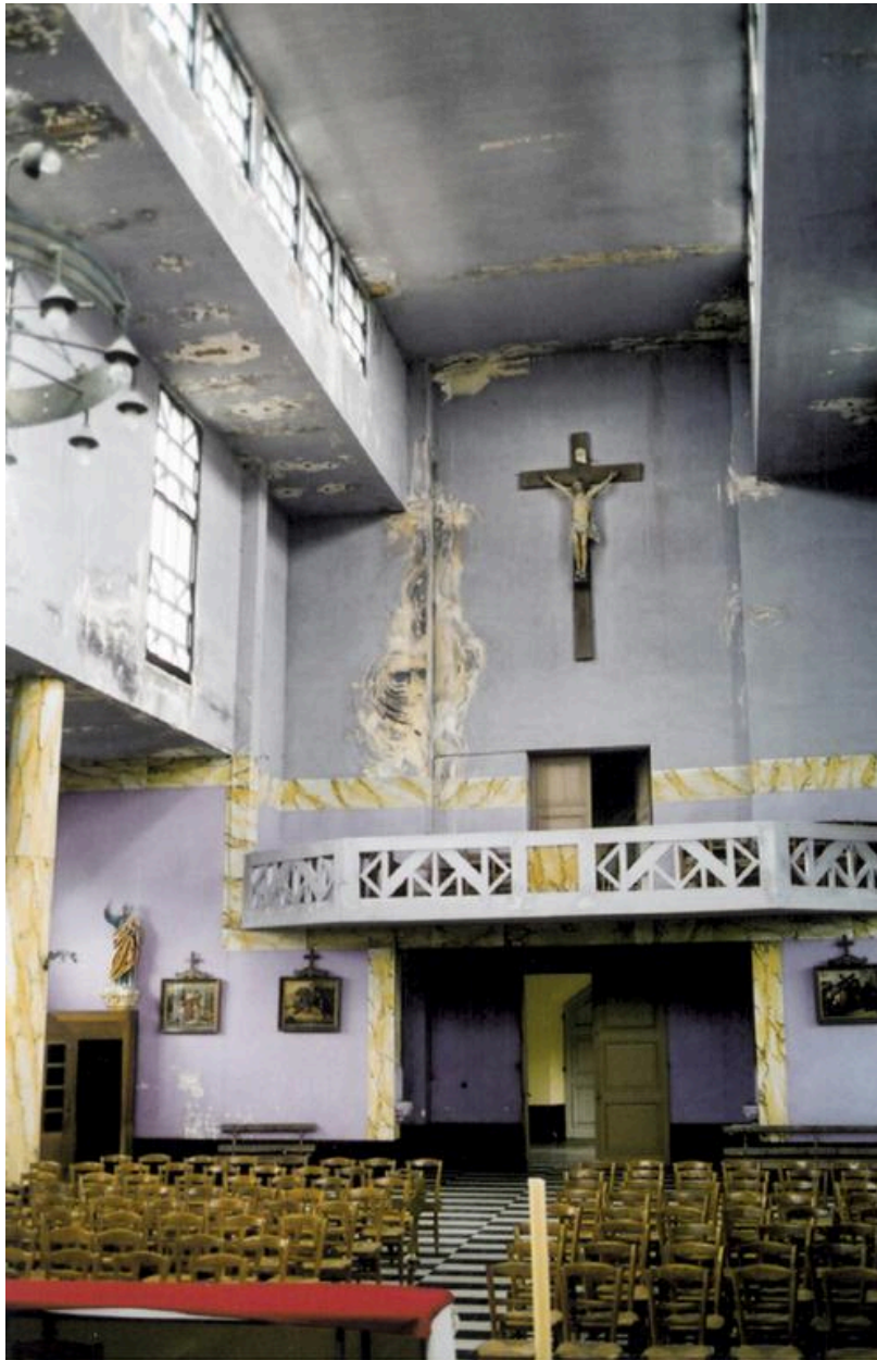
Vue intérieure vers la nef.
