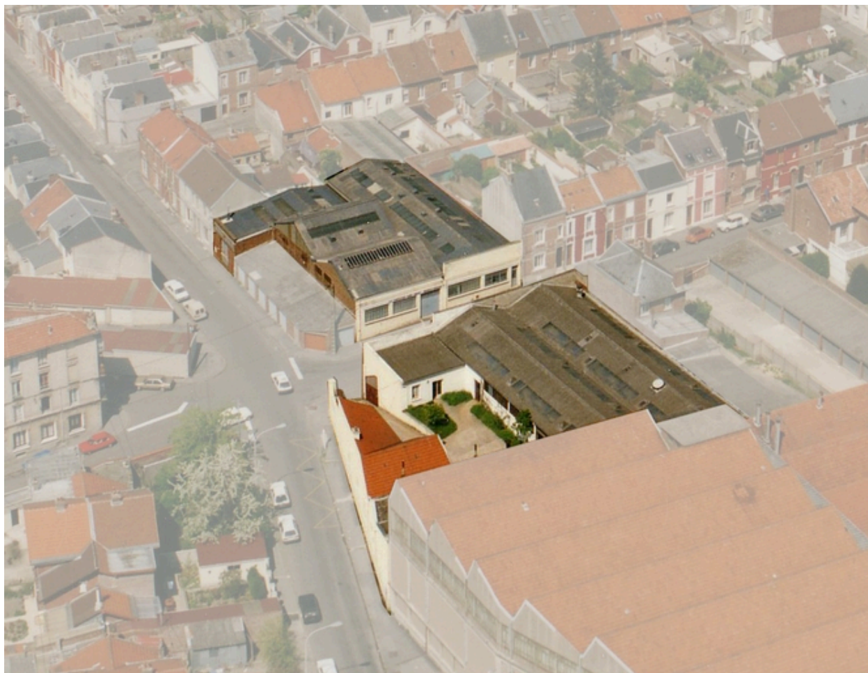
Vue aérienne vers 1989 (BM Saint-Quentin).
