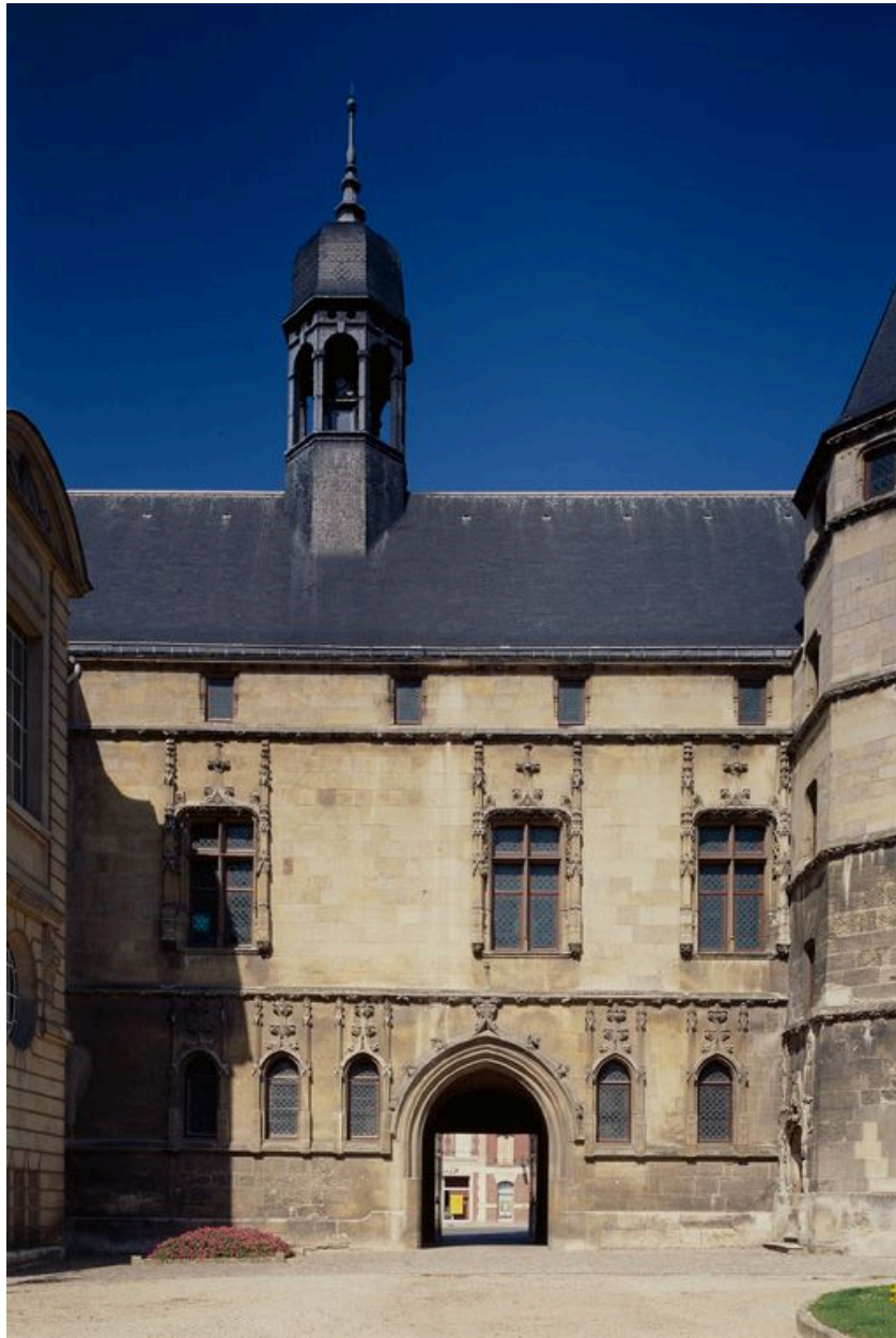
Elévation postérieure, détail.
