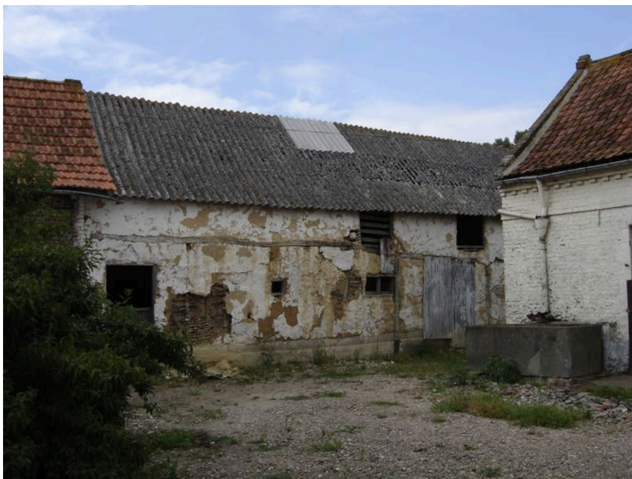
Vue de la grange.
