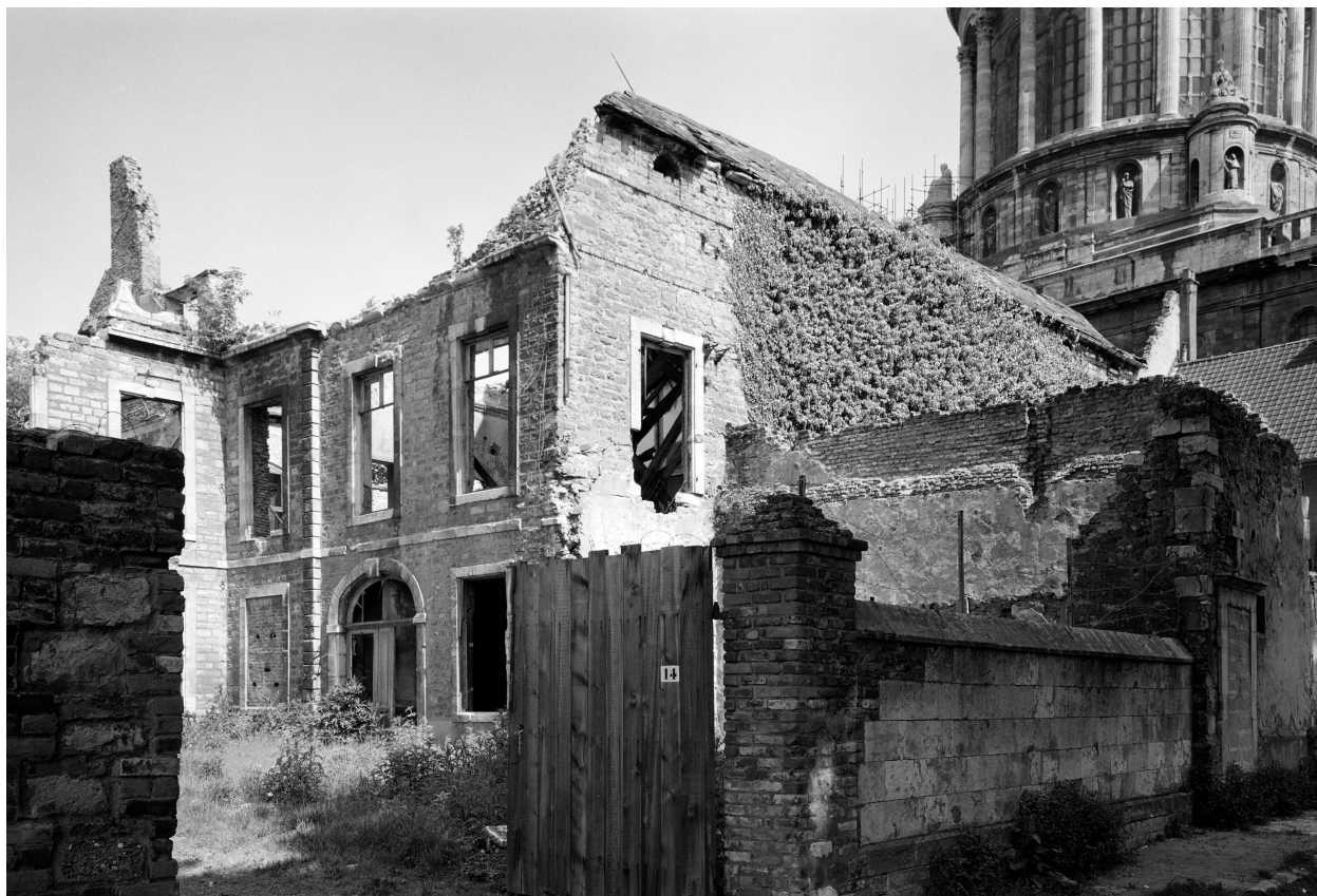
Façade sur l'Enclos, vers église.
