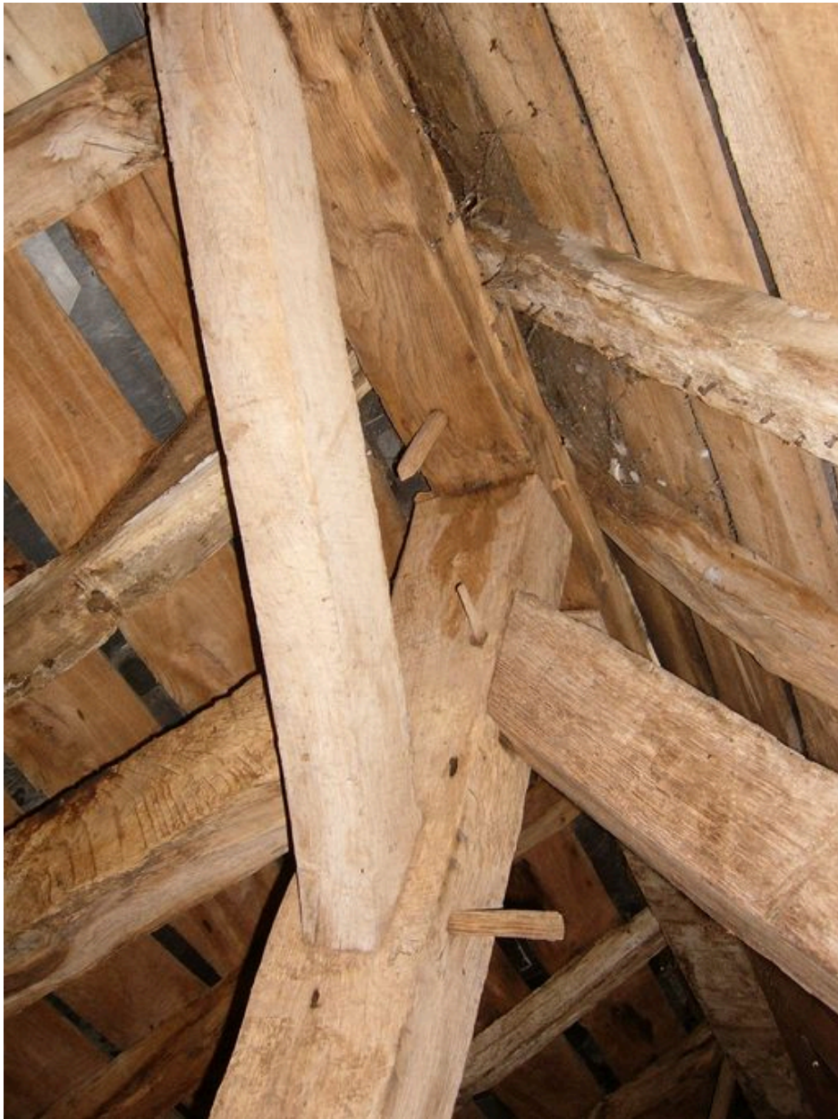
Détail de la charpente.
