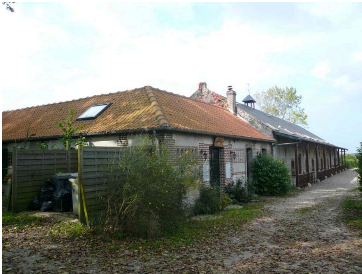
Vue des étables à l'est.
