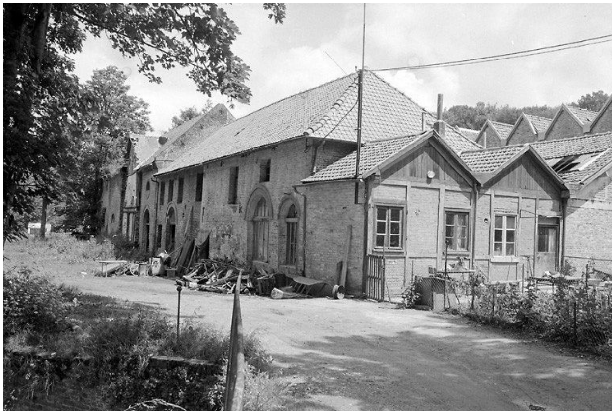
Atelier de fabrication, flanc ouest.
