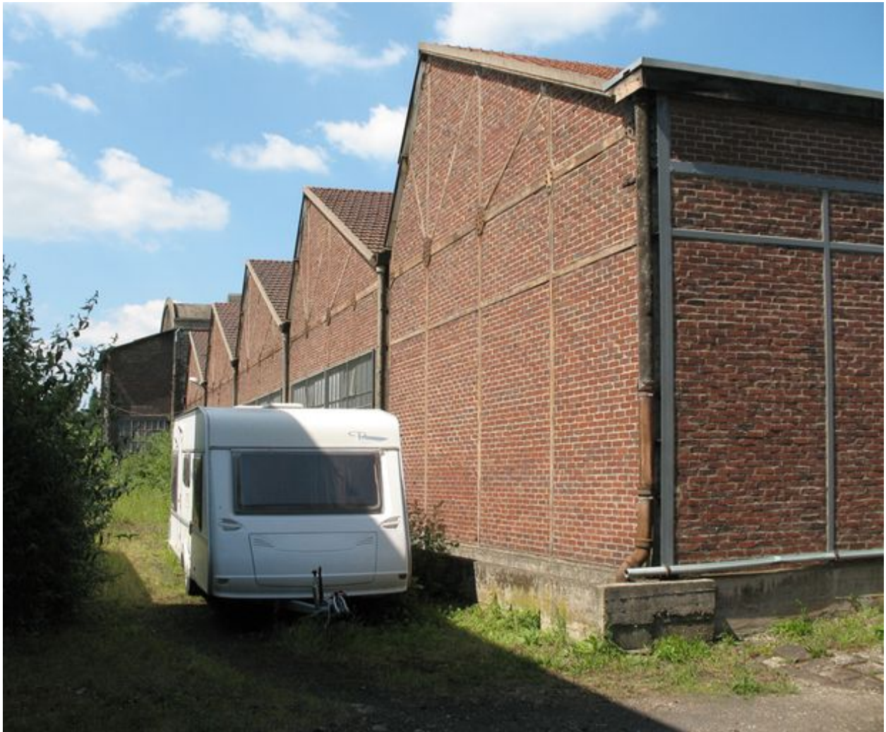
Façade ouest des ateliers d'emballage et de conditionnement.
