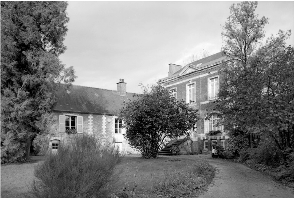
Vue du logis : aile de style Louis XIII (à gauche) et partie rajoutée au 19e siècle (à droite).
