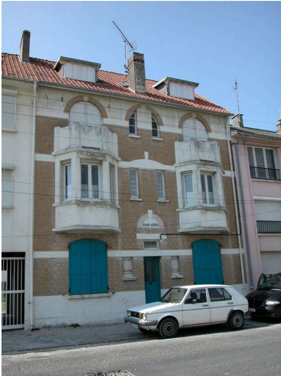
Bow-windows de l'immeuble Sans Adieu (108 Bd Intérieur).
