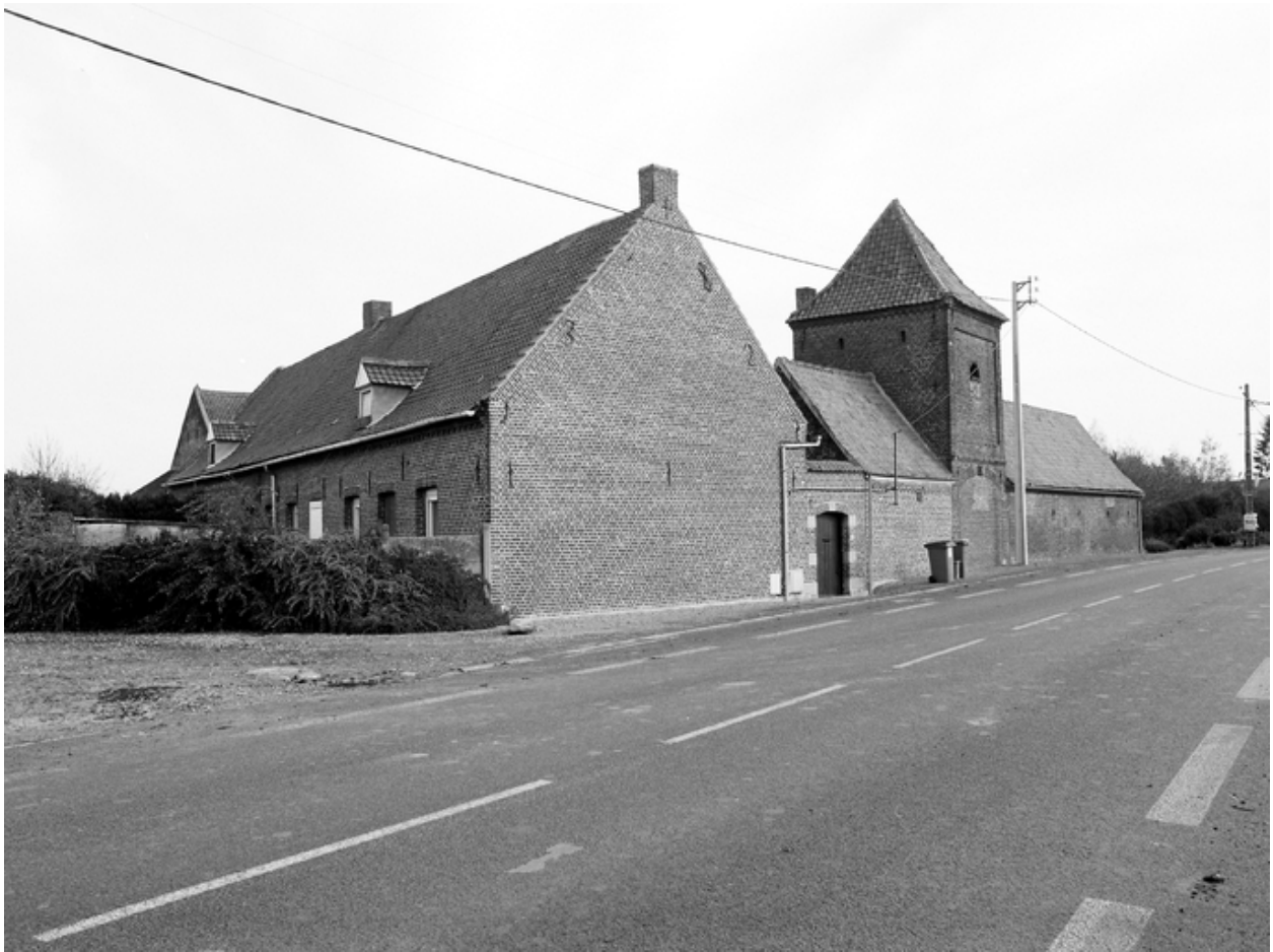
Ferme, 443, rue du Grand Chemin, vue générale.
