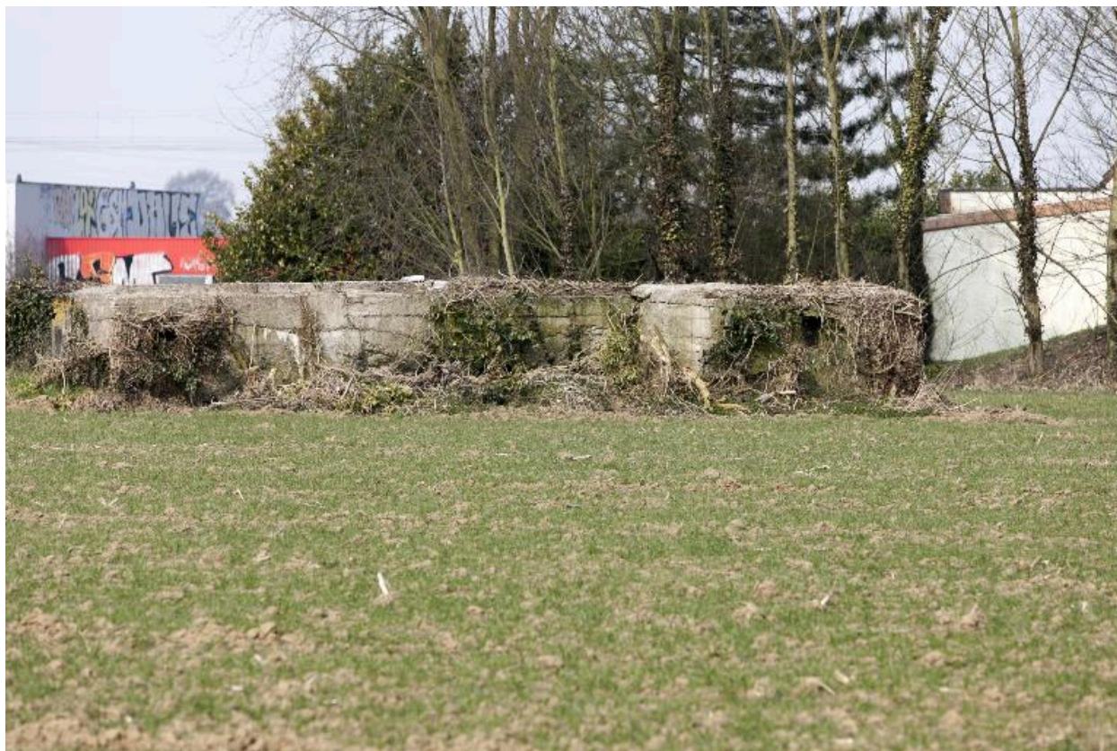
Ouvrage en U
