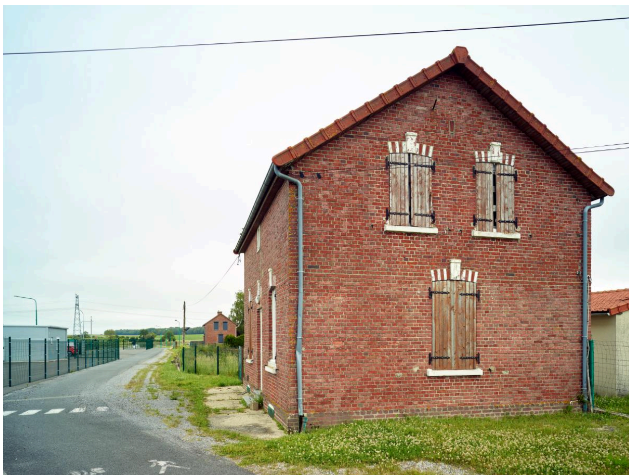
La maison de service (aval).
