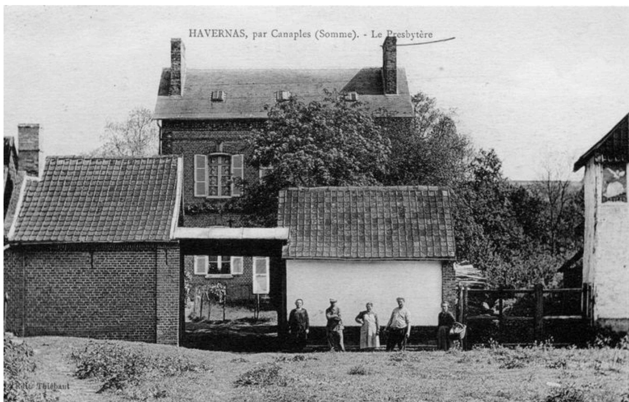
Vue générale depuis la rue, 1920-1930 (coll. part.).
