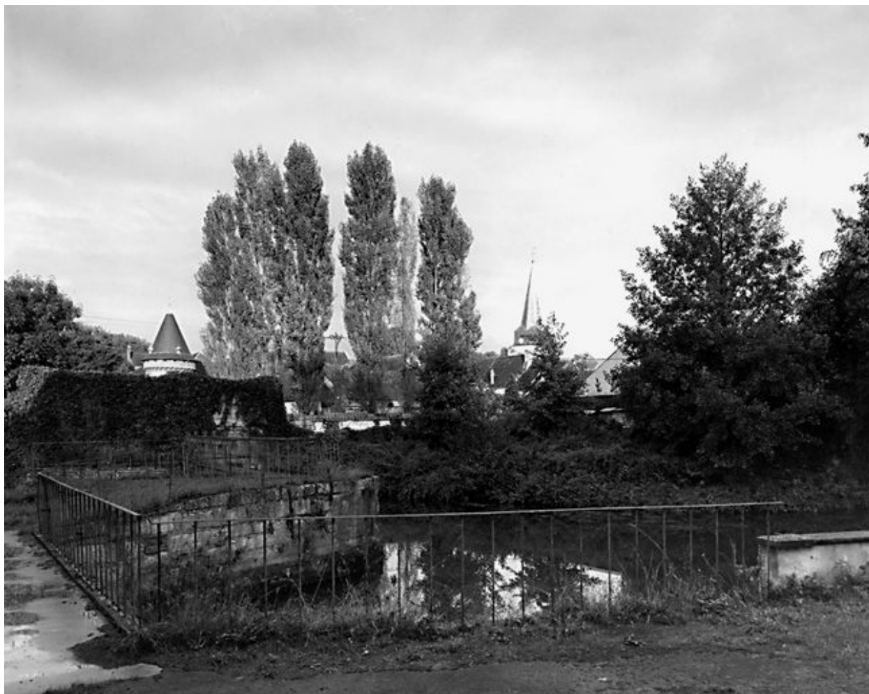
Vue éloignée de la ville depuis la filature.
