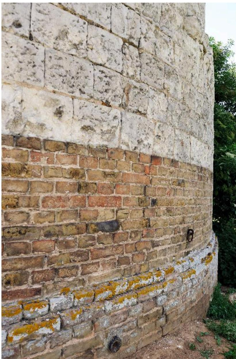
Détail de l'appareil du mur : pierre de taille et solin de brique.
