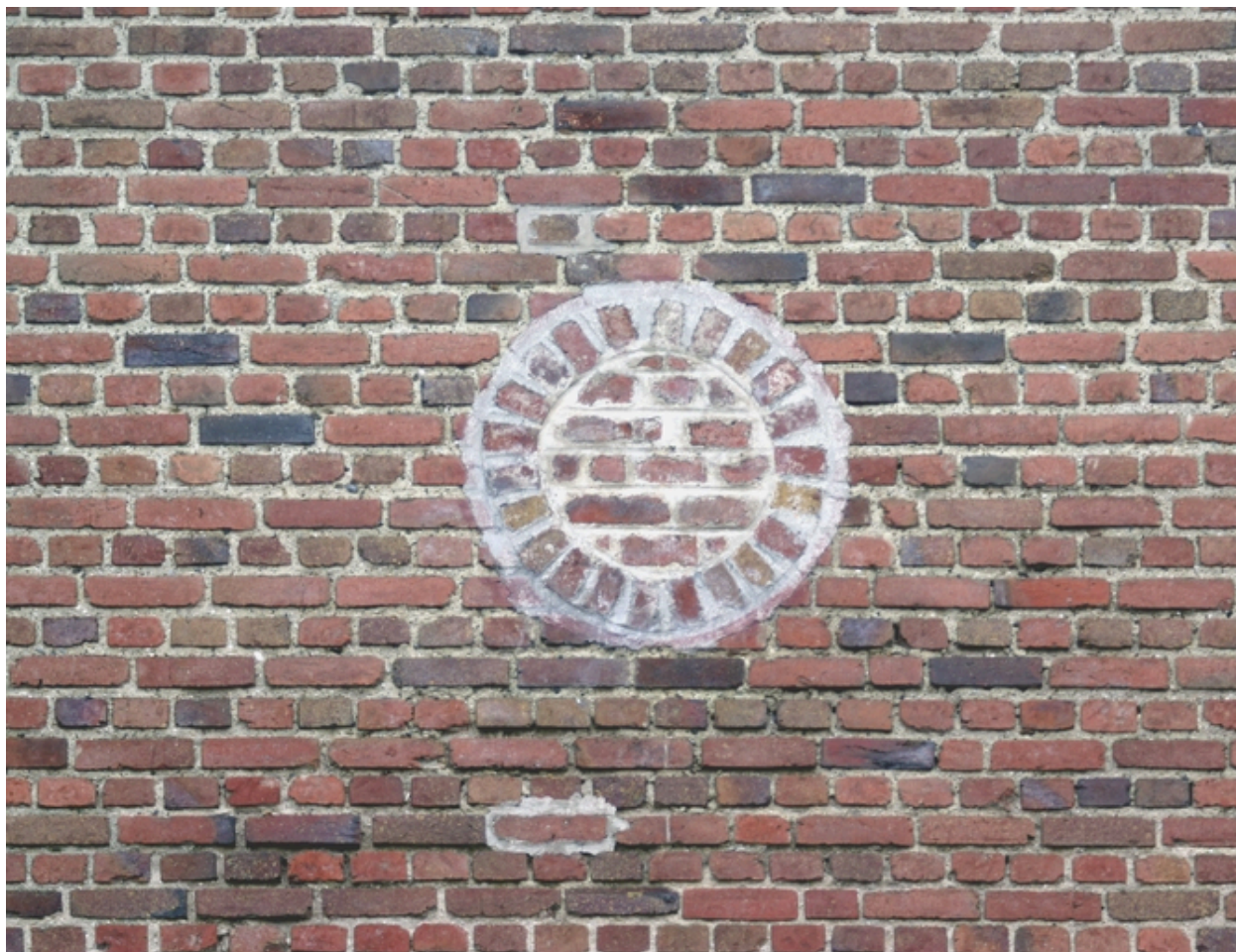
Maçonnerie de brique et ancien oculus.
