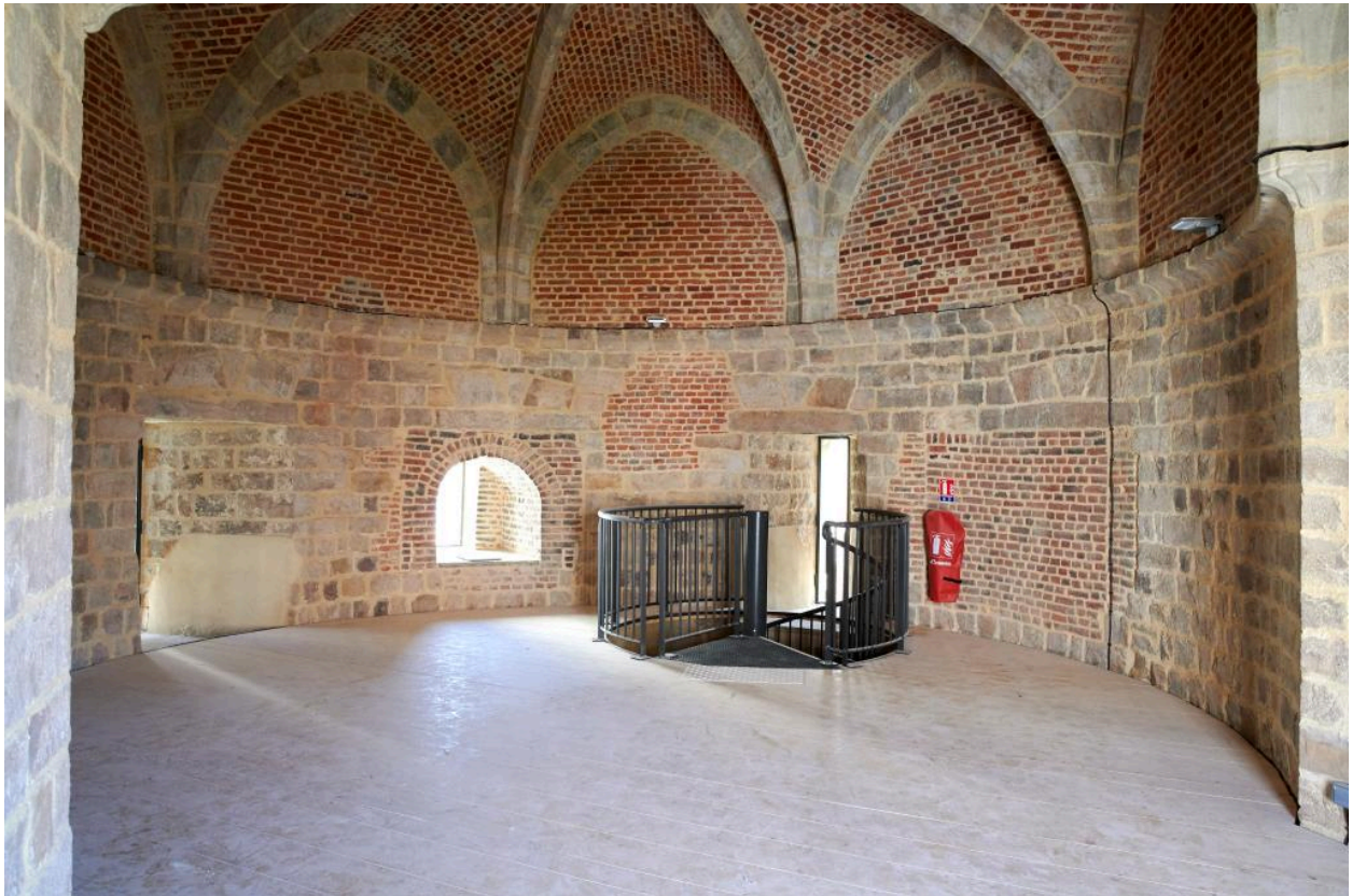
Vue d'ensemble du premier niveau, vers le sud.
