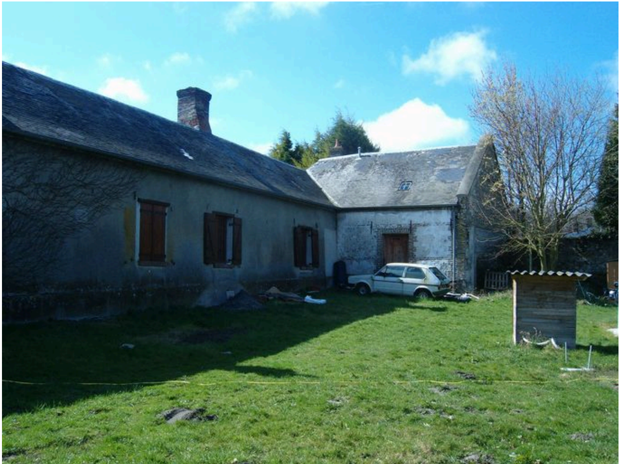
Vue postérieure de la maison accompagnée de la cave à cidre.
