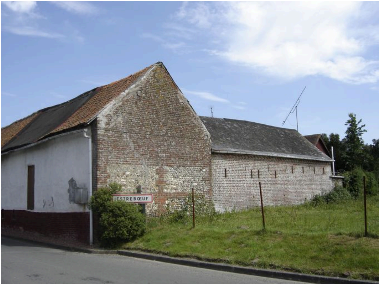
Vue extérieure des bâtiments annexes.
