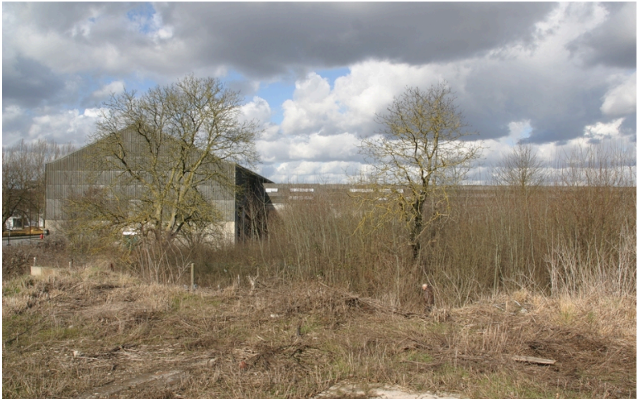
Les ateliers vus depuis le site voisin de l'ancienne fonderie Lefèvre, Leroy et Cie.
