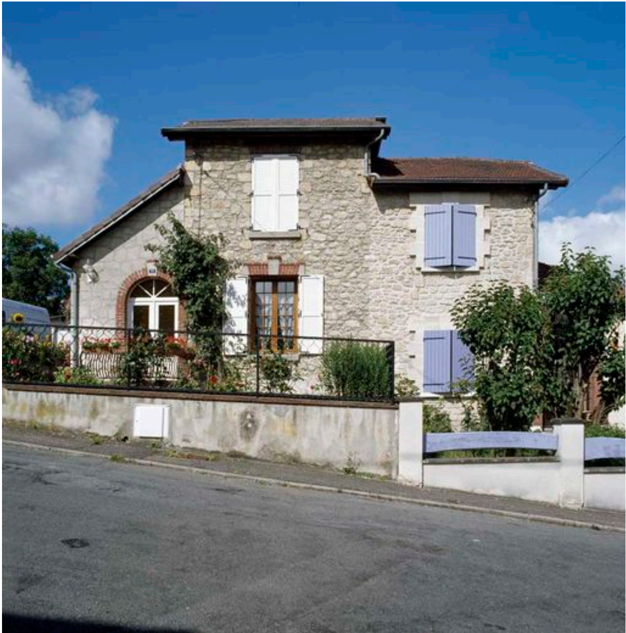
Logements jumelés de la cité Mimbertain.
