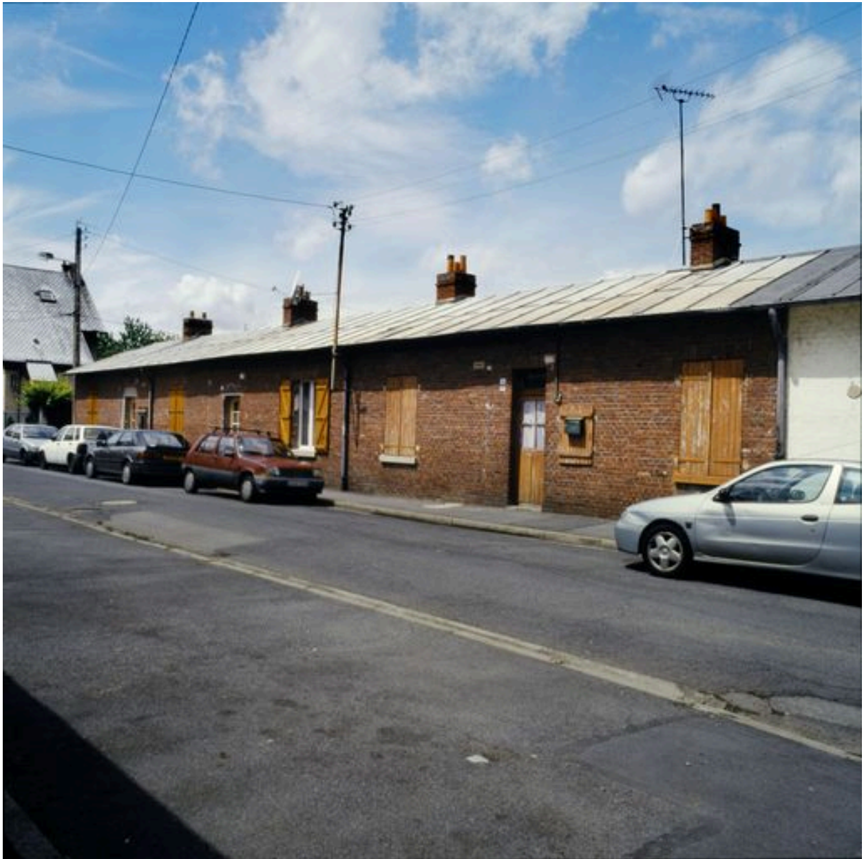
Maisons en rez-de-chaussée et leurs toitures d'origine en zinc.
