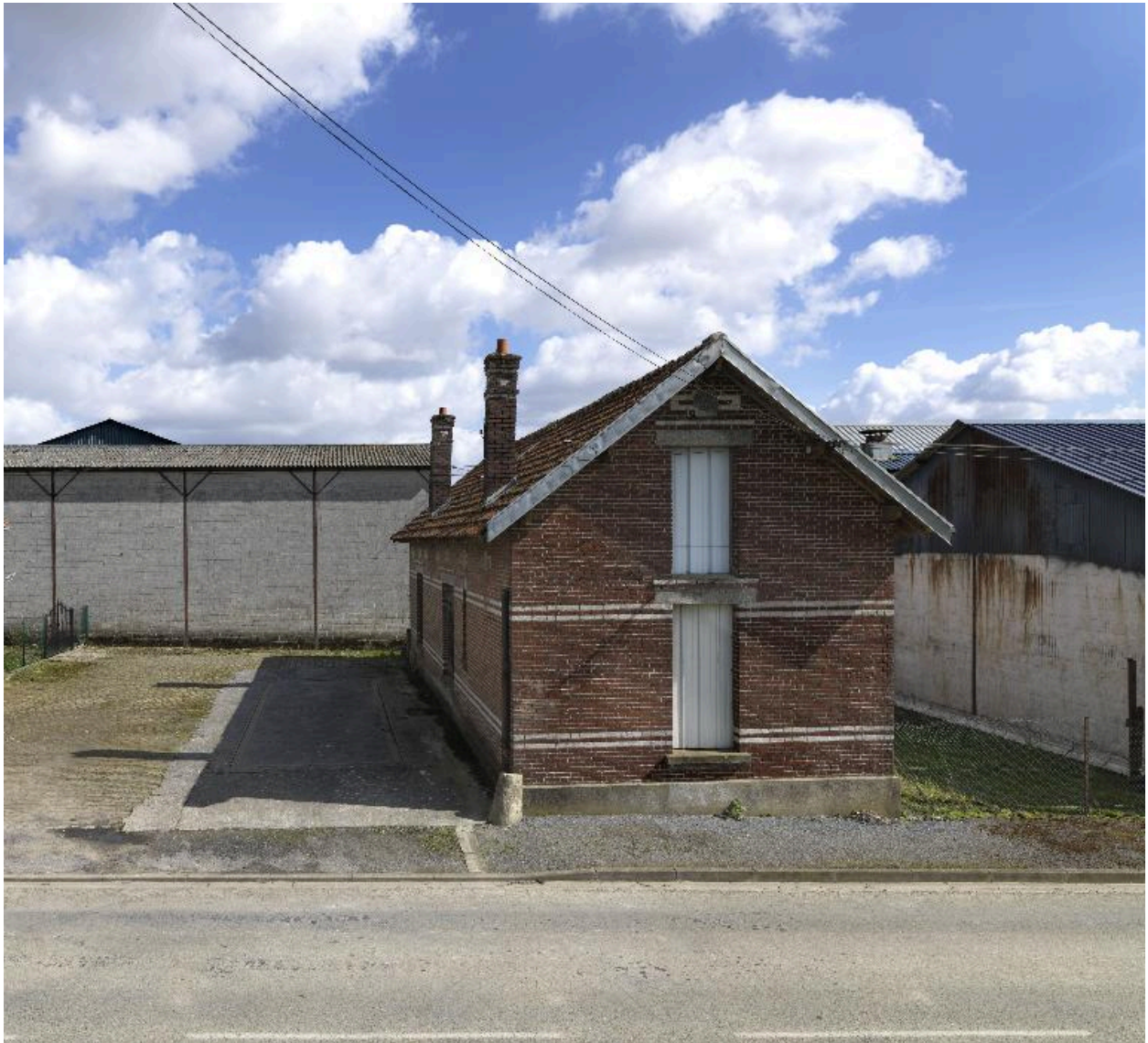
Bureau de pesée avec sa bascule à l'ancienne entrée de l'usine.
