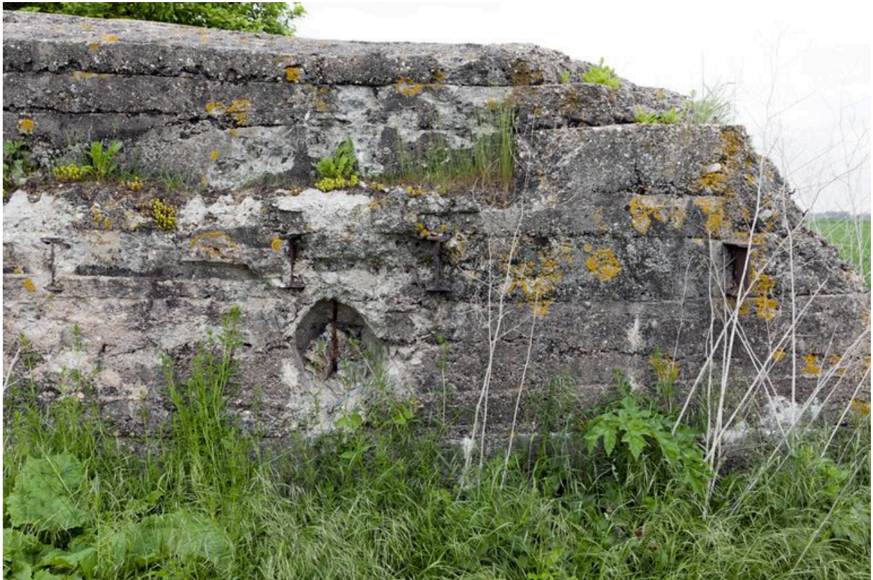
Vue latérale, vers le nord-est, détail des poutrelles.
