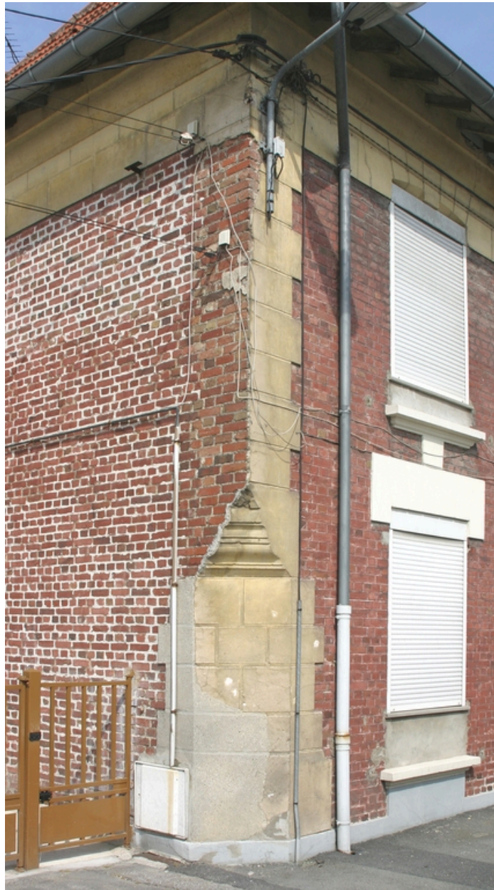
Détail d'un enduit imitant un appareillage en pierre de taille, sur un des deux pavillons d'entrée.
