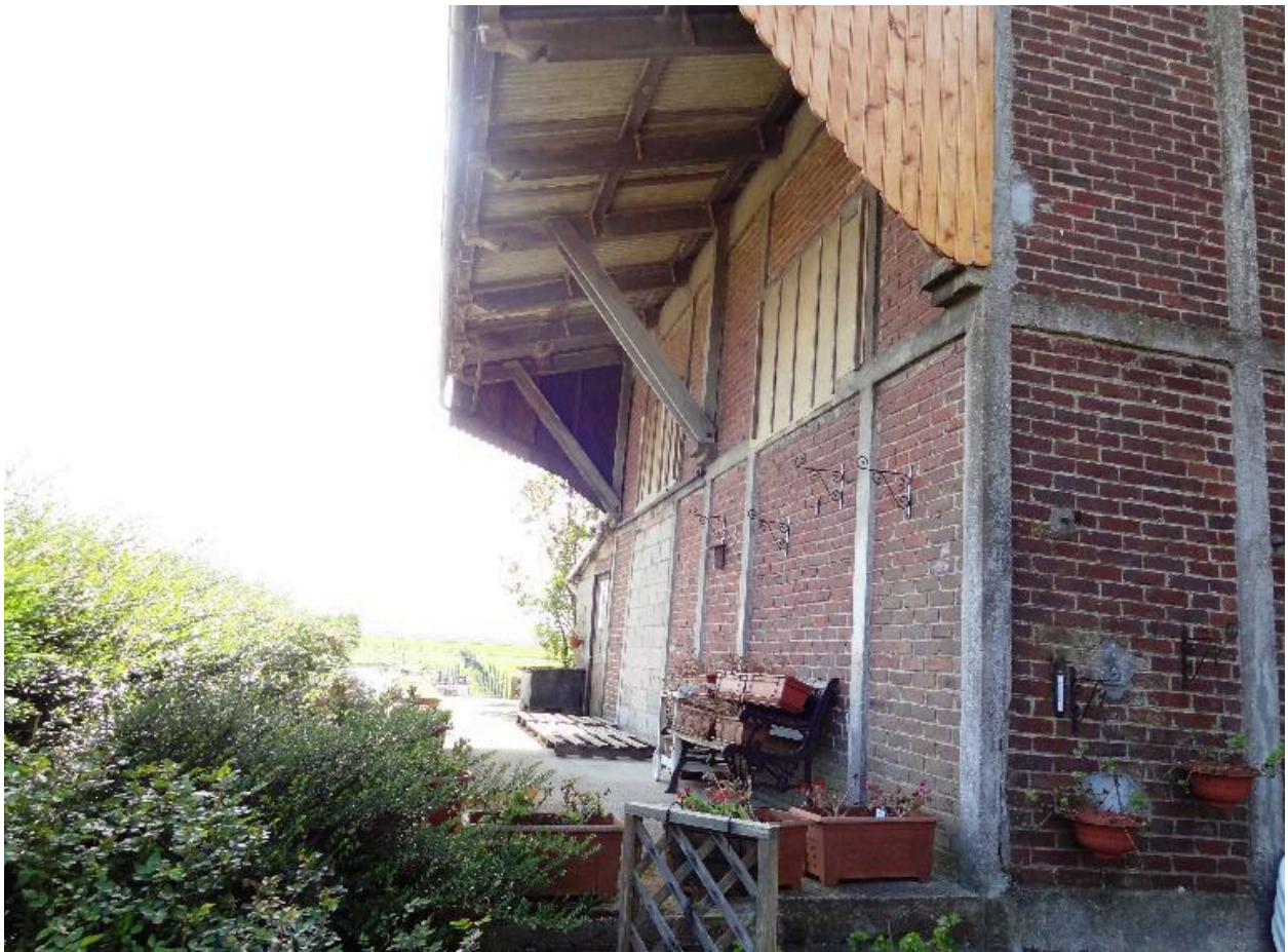
Vue actuelle de l'ancien quai et de l'ancien hangar de la gare de Saint-Quentin-la-Motte-Croix-au-Bailly.
