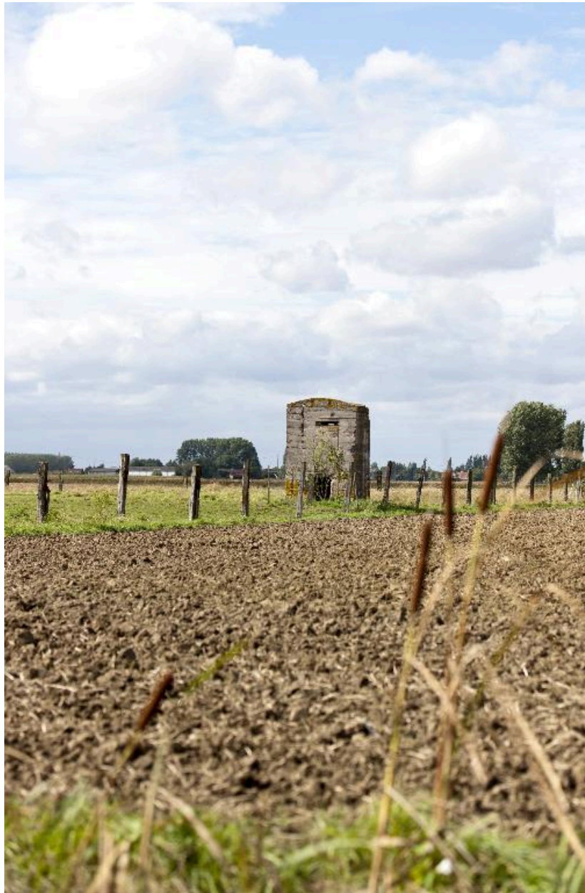
Vue générale vers le nord-ouest
