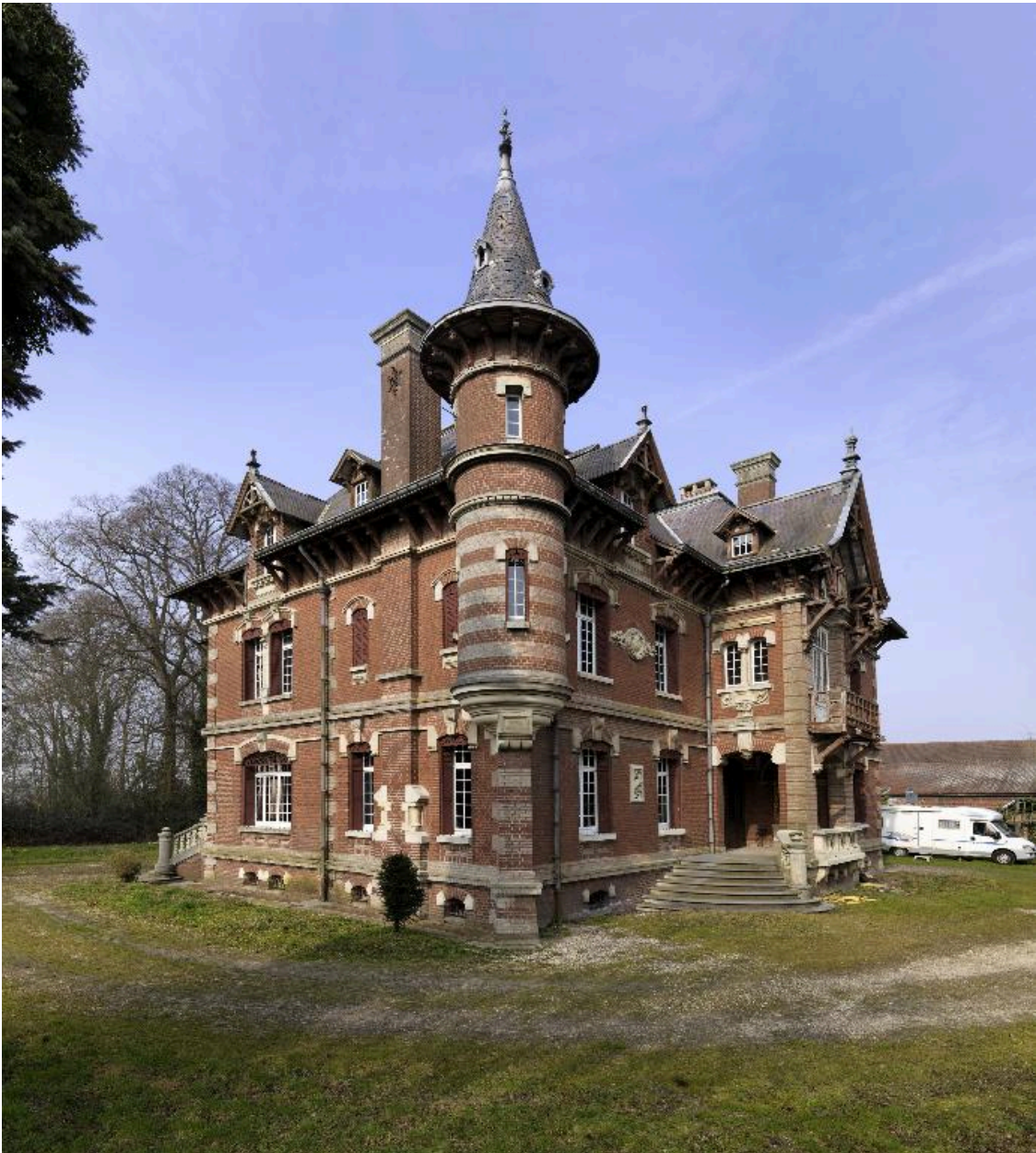
Vue de trois-quarts sud-ouest.
