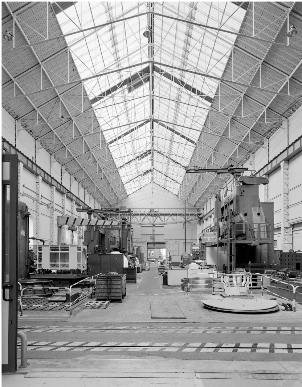
Vue générale intérieure de la halle 10 nord : atelier de grosse mécanique.
