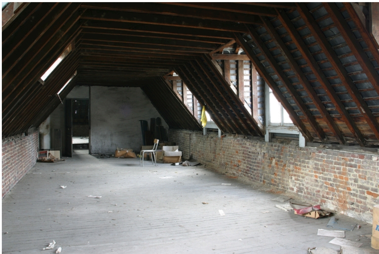
Combles de l'atelier bordant la rue de Vesoul.
