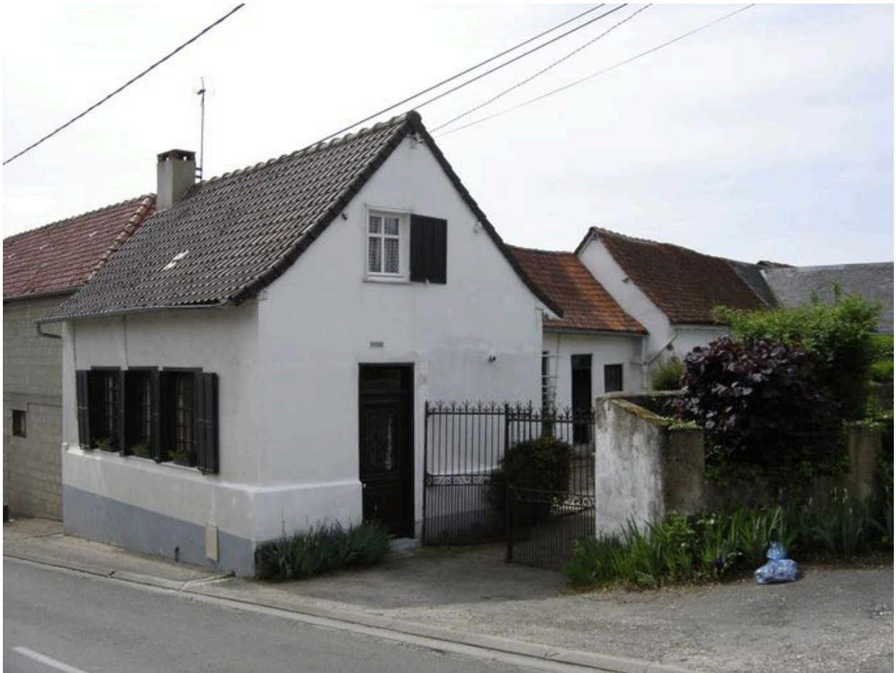
Vue du logis depuis la rue.
