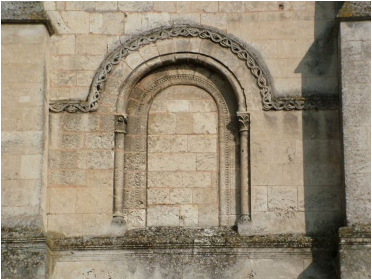
Fausse-fenêtre au premier niveau de la tour-clocher.
