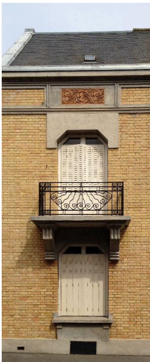
Vue de détail d'une travée de la façade sur rue.
