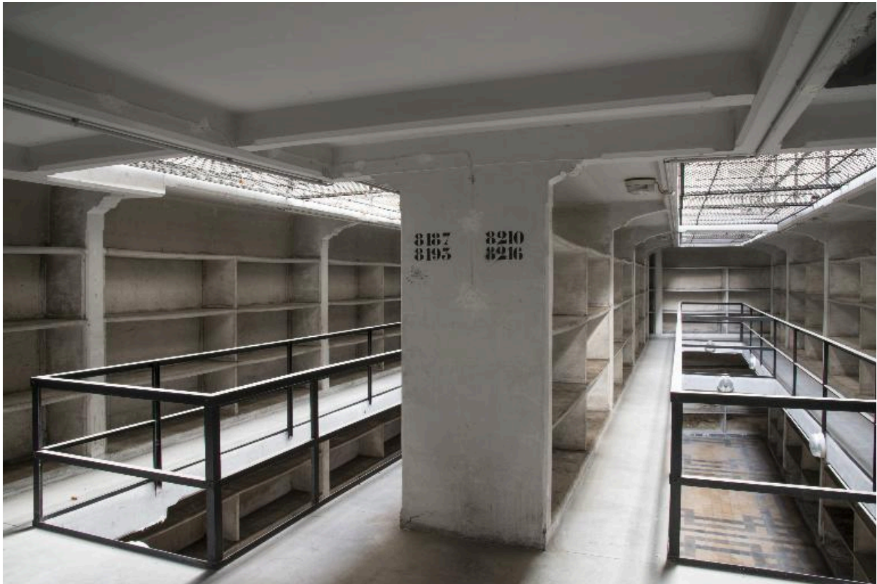
Bâtiment du dépôt, premier étage : vue des vaisseaux 1 et 2, vers l'est.
