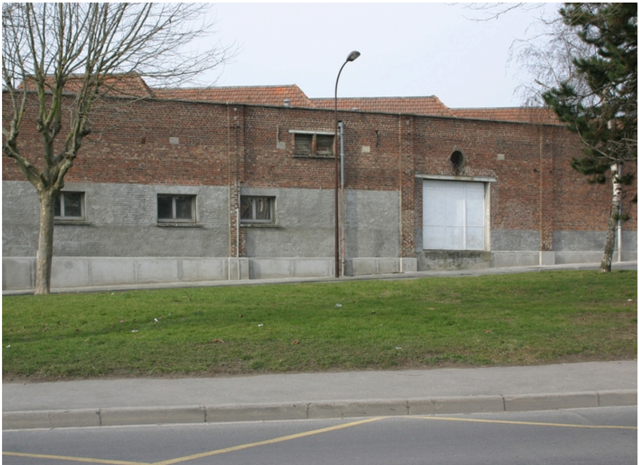
Façade des ateliers de 1921, rue Ribaudois.
