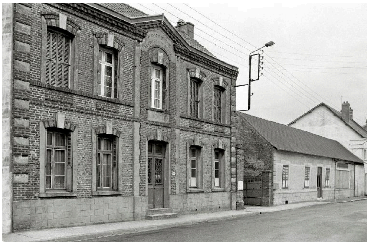
Vue d'ensemble depuis la rue Isaïe-Sellier, en 1990.
