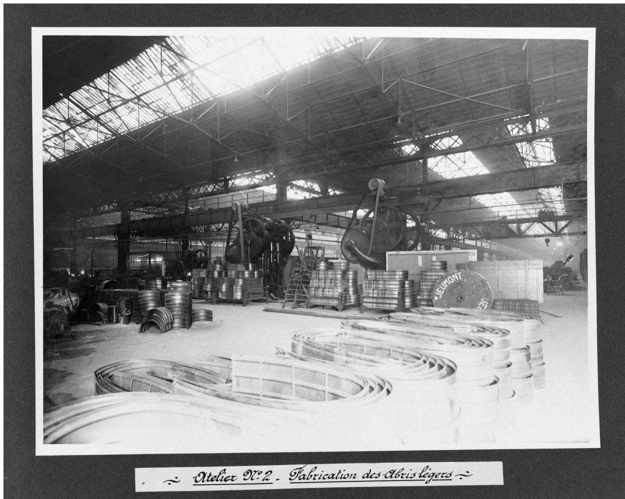
Atelier n° 2 : la fabrication des abris légers, 16 février 1940. Photographe inconnu (coll. part., archives Cerec).
