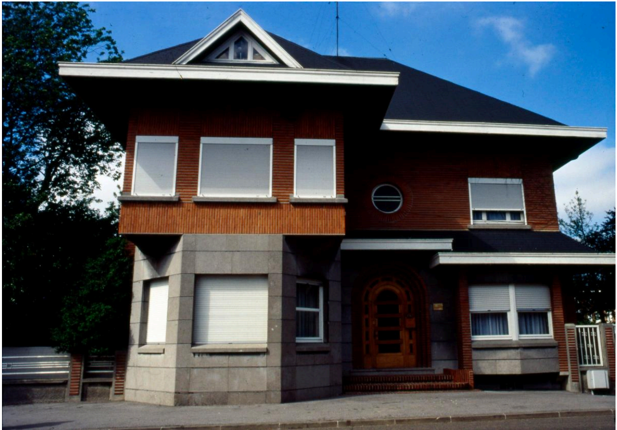
Maison sise au n°27 de la rue Jean-Cattelas, construite par Adolphe Danis en 1955-1959.
