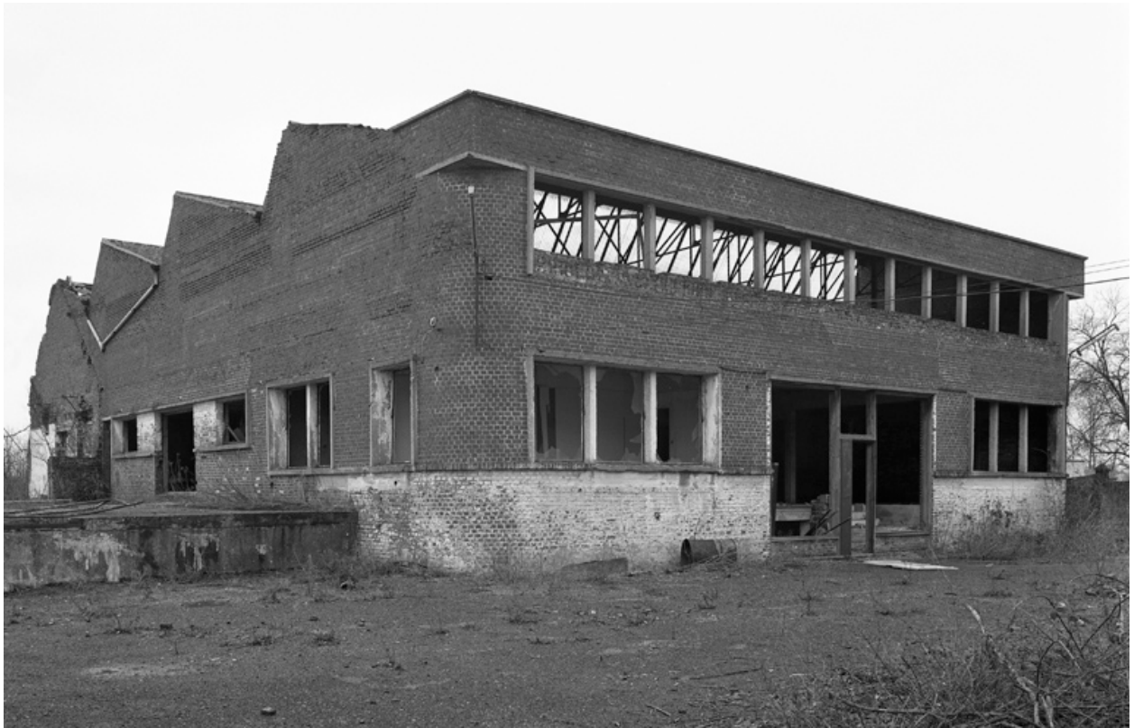
Vue sud-ouest des anciens ateliers de fabrication.
