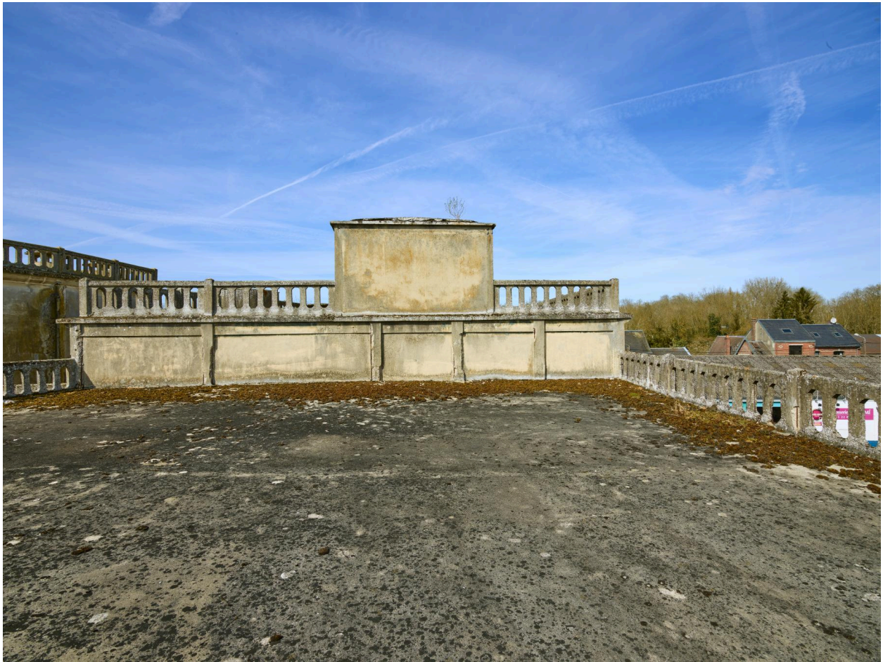
Toit-terrasse de la minoterie.
