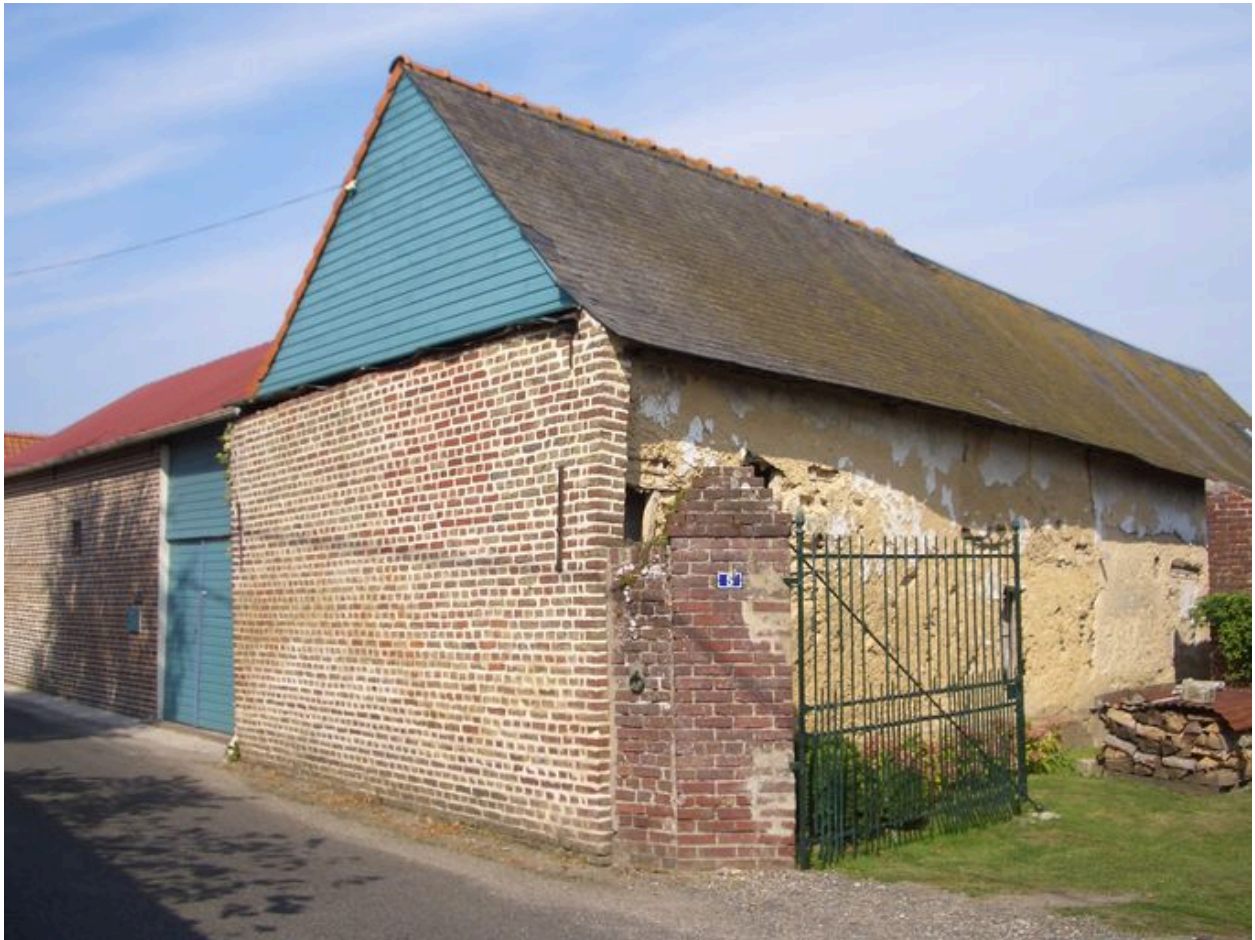
Vue de la grange.
